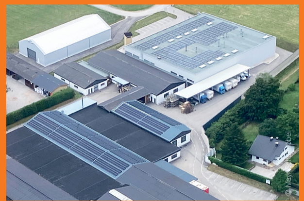
Mayr Schulmöbel investierte in eine weitere Photovoltaik-Anlage.
